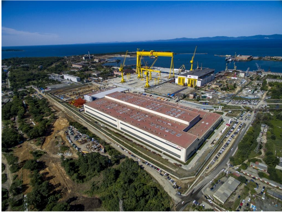
Рисунок 1.2.1.4 – Вид сверху на судостроительный комплекс «Звезда» [86]
